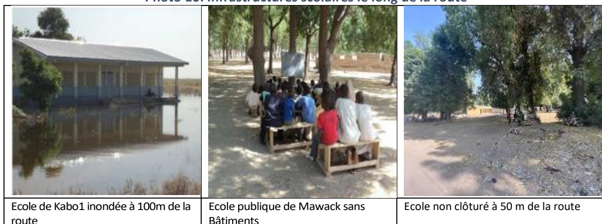
Photo 10: Infrastructures scolaires le long de la route
